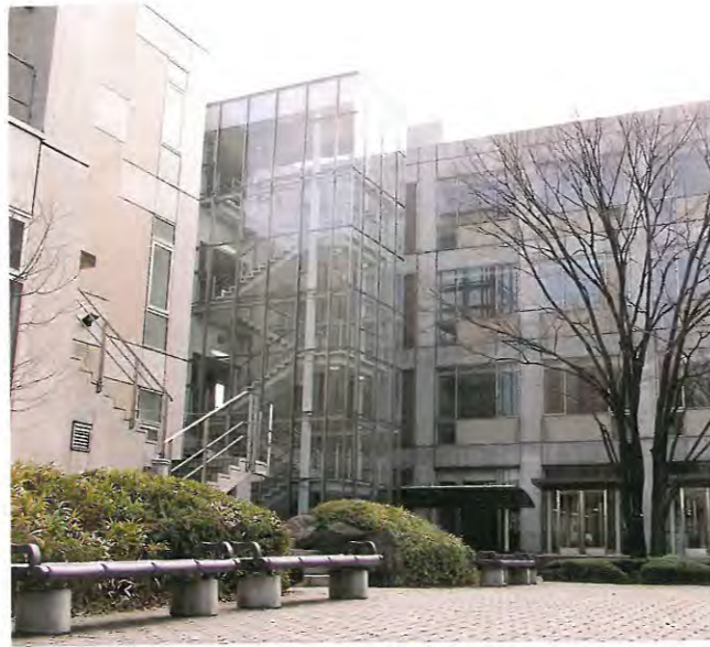
テラス広場から西館●West Building
